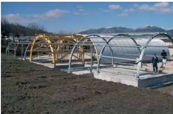
Figura 4 - Immagini di cantiere. Fase di montaggio dei pannelli poliuretani sandwich sulla struttura in legno lamellare del corpo centrale e in acciaio delle ali laterali
