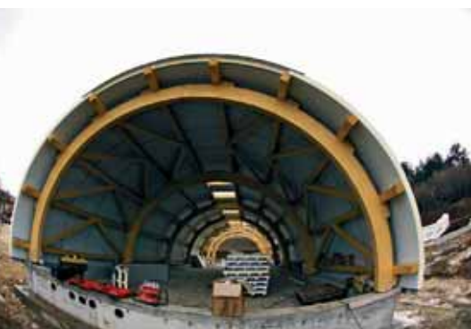
Figure 5, 6 e 7 - Immagini di cantiere. Fase di montaggio dei pannelli poliuretanici sandwich sulla struttura in legno lamellare del corpo centrale e in acciaio delle ali laterali
