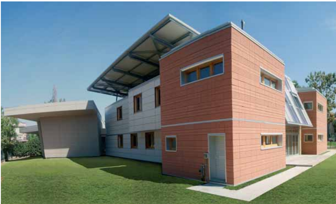
Figura 3 - Casa per minori Don Leandro Rossi a Lodi, di E. Zambelli/Studio AIACE S.r.l., vista del fronte sud-ovest
