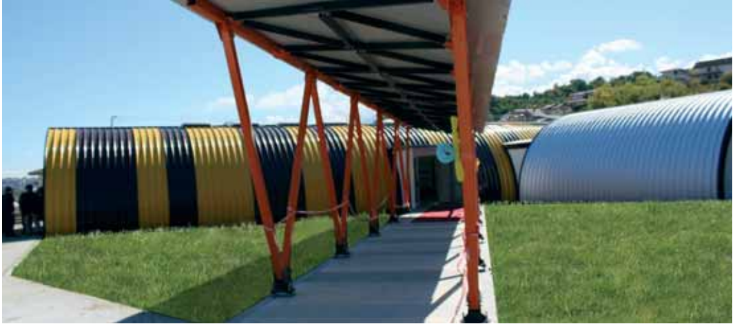
Figura 3 - Vista dell'ingresso. In evidenza la pensilina tecnologica in acciaio composta da moduli prefabbricati
