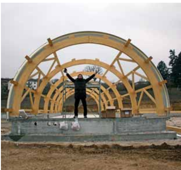
Figure 5, 6 e 7 - Immagini di cantiere. Fase di montaggio dei pannelli poliuretanici sandwich sulla struttura in legno lamellare del corpo centrale e in acciaio delle ali laterali
