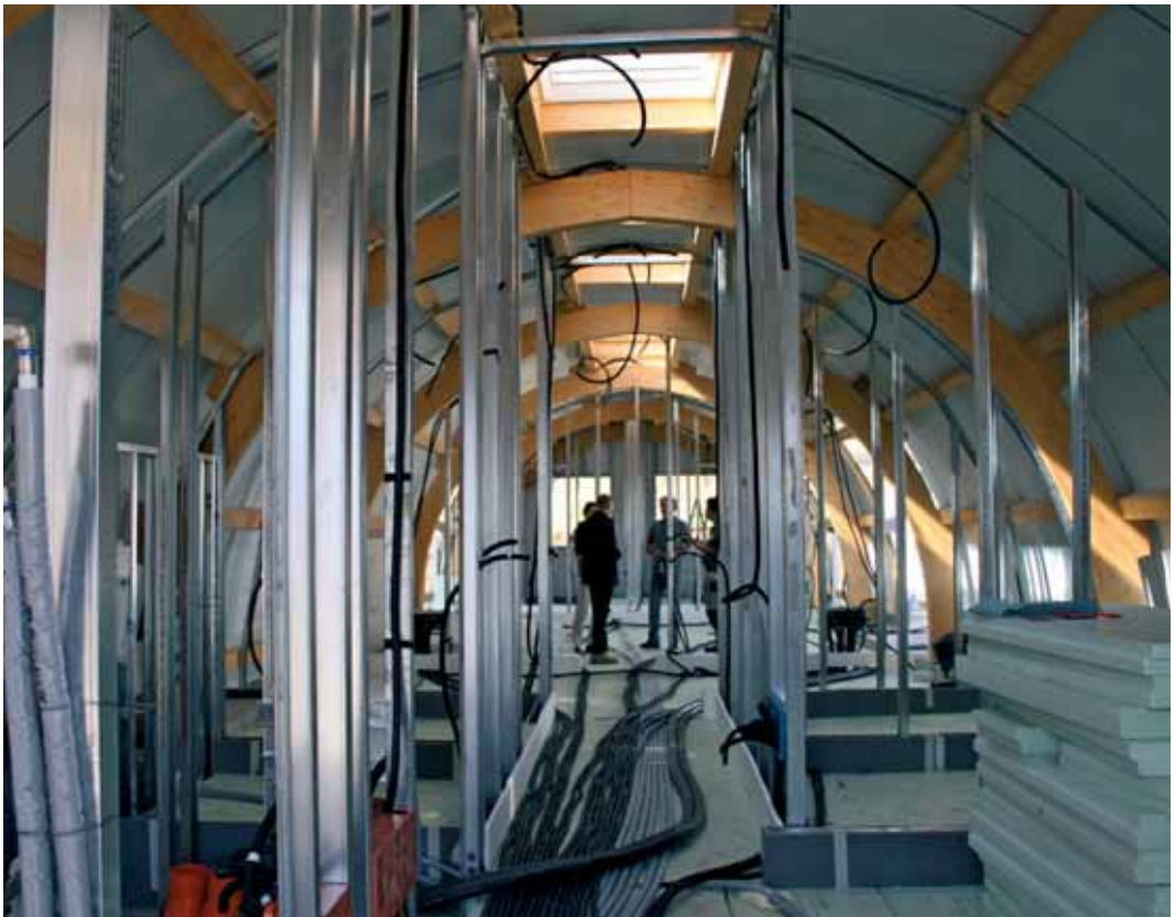
Figura 18 - Immagini di cantiere. Posa degli elementi di chiusura realizzati con tecnologia a secco e condotti impiantistici
