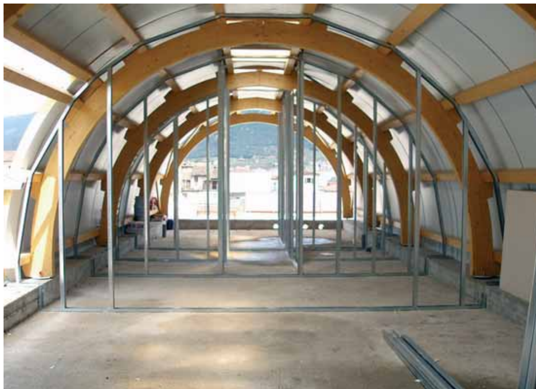
Figura 19 - Immagini di cantiere. Posa degli elementi di chiusura e delle partizioni interne realizzate con tecnologia a secco
