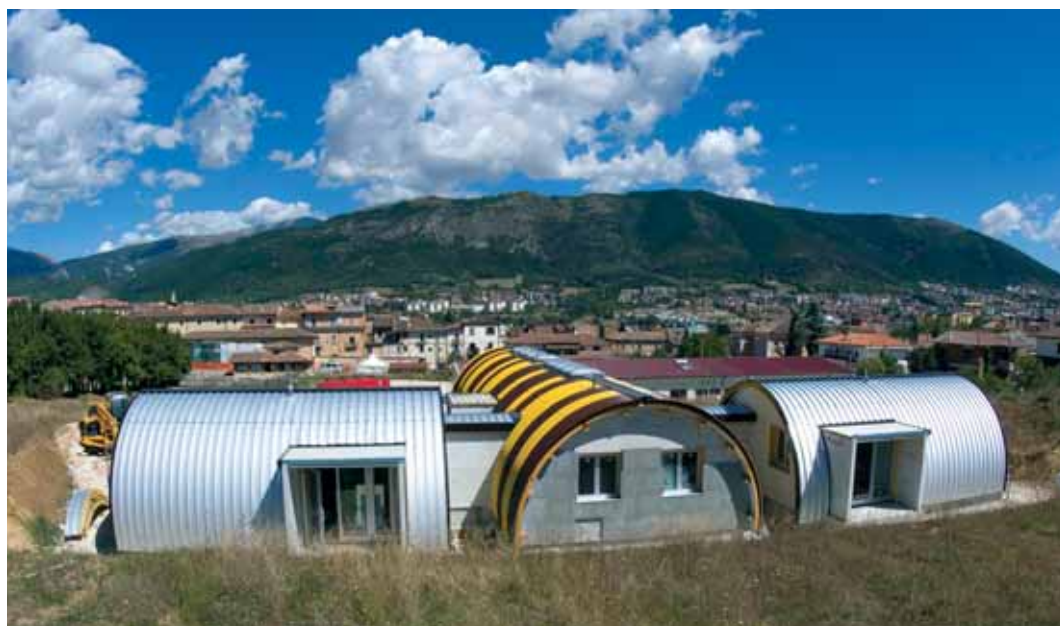
Figure 13, 14 e 15 - Viste della scocca in lamiera zincata
