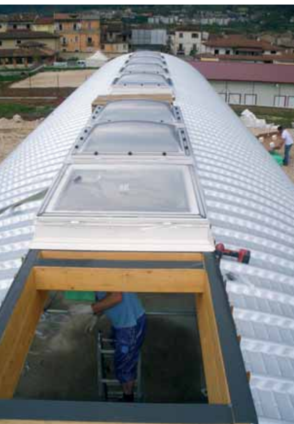
Figura 16 e 17 - Dettaglio dei cupolini di ventilazione Velux
